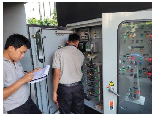
เจ้าหน้าที่ดูแล ตรวจสอบตู้ควบคุมระบบบำบัดน้ำเสีย
